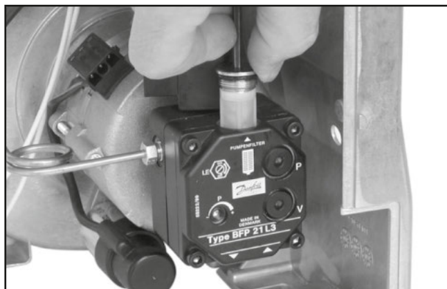
Figure 25 — Démontage du filtre à fioul
